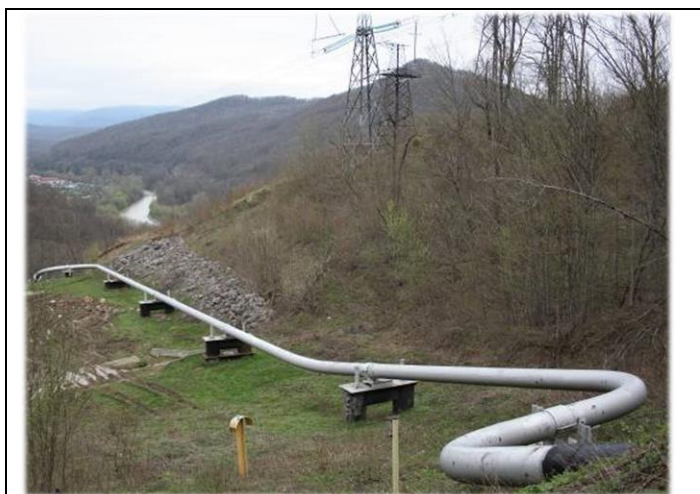
Рис. 2. Участок трубопровода с существенным перепадом высотных отметок опор
